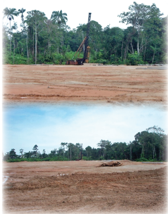
Gambar 22: Projek Mahkamah Baru Balik Pulau dalam pembinaan
