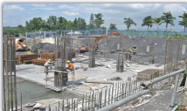
Gambar 25: Projek Bangunan Tambahan Mahkamah Sesyen/Majistret Shah Alam Dalam Pembinaan
